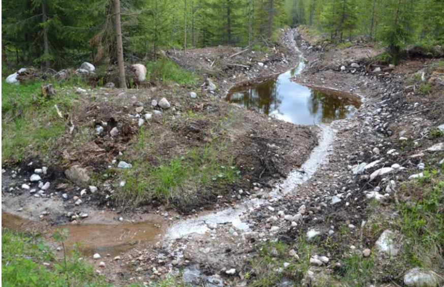
Figur 1 Exempel på slamgrop/sedimentationsfälla. (Foto från Skogsstyrelsens bildarkiv) Se längst bak i detta dokument för en principskiss på slamgrop i vägdikey innan bäck.
